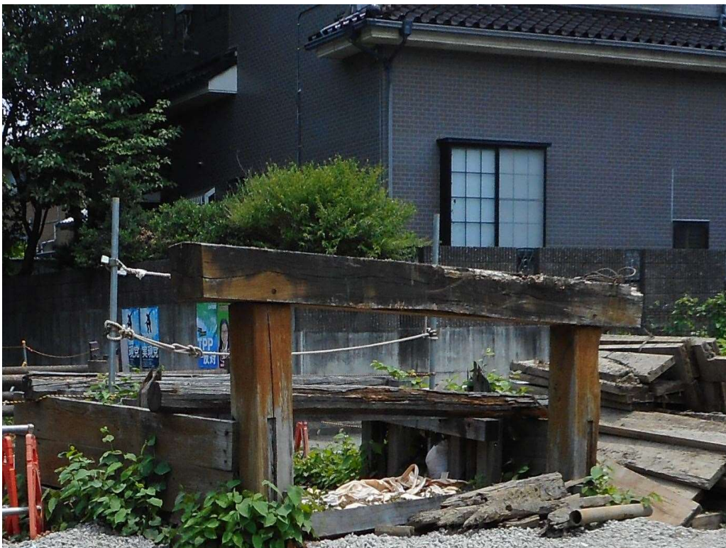
見沼通船堀の関(復元工事中)
