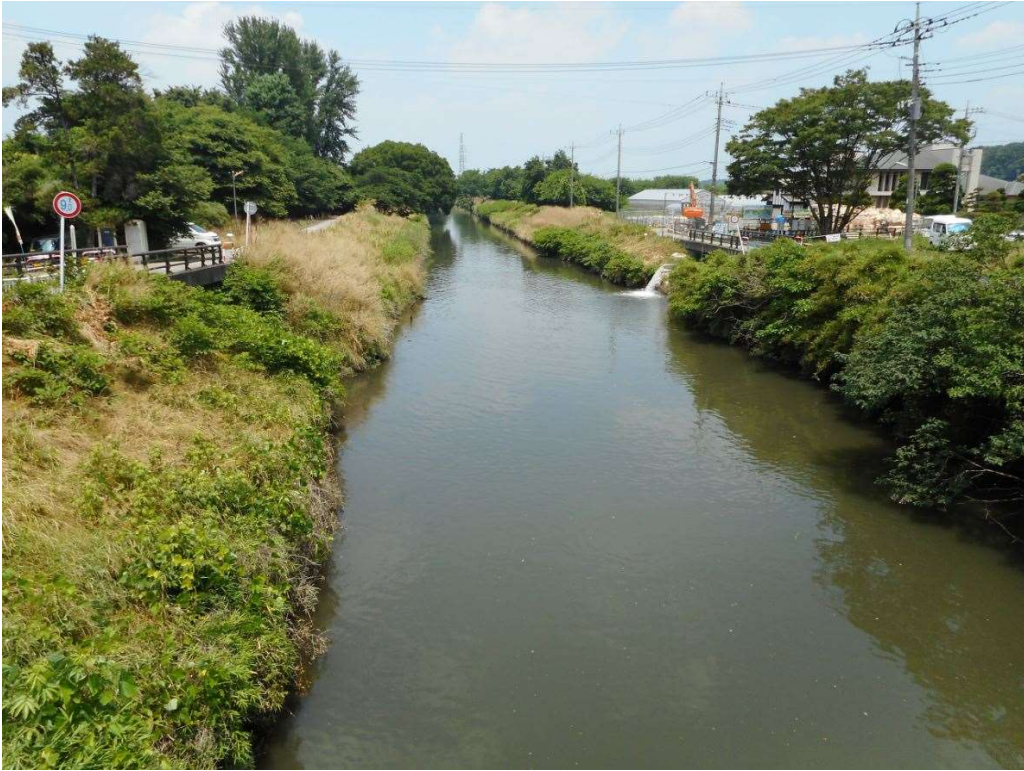
芝川(排水路、悪水)
