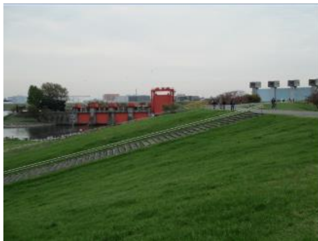
旧岩淵水門（オレンジ）と岩淵水門（水色）
