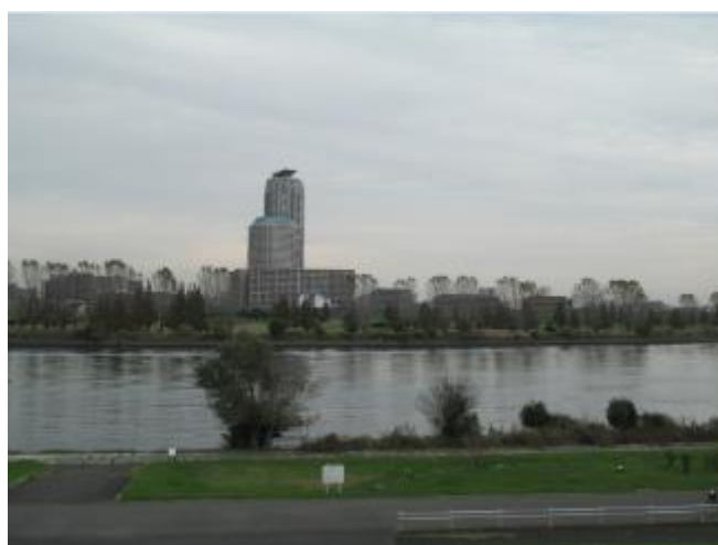
荒川と川口市の高層住宅、エルザタワー55 185m
