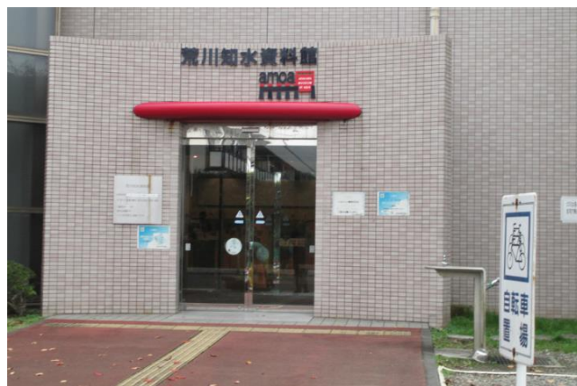
荒川知水資料館
