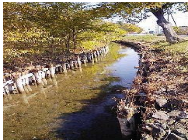
松杭と石を用いた護岸
