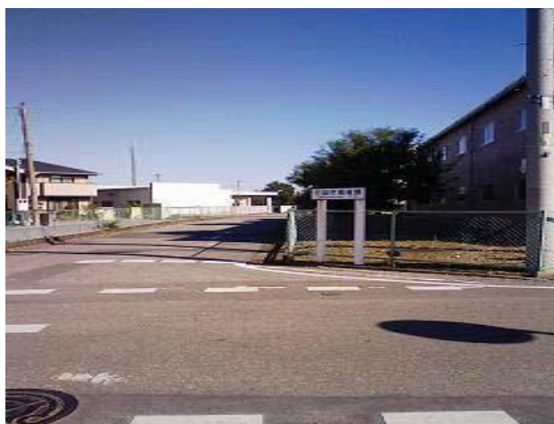
環境センター、緑町ポンプ場
