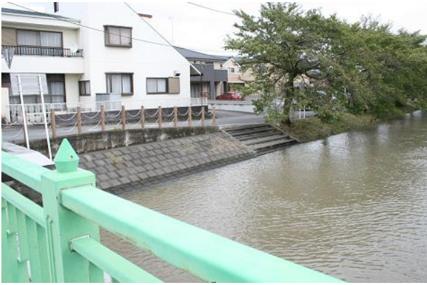
台風による増水時の平成橋付近
