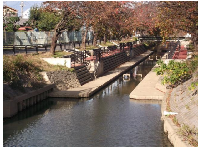
花見橋付近、濁水時の酒巻導水路（11月）
