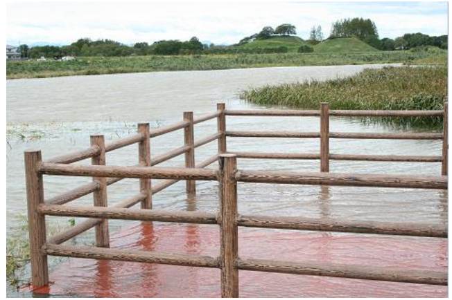
台風による増水時の旧忍川・共栄橋付近
