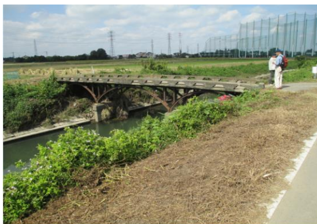
樋上 1 号橋 (橋名の表示はない)
