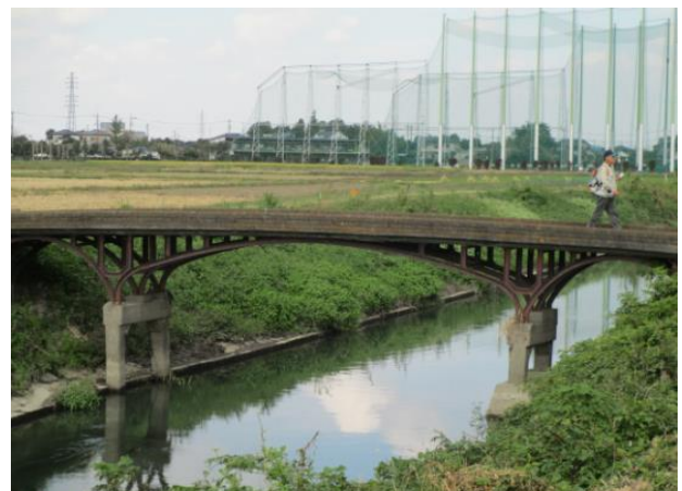
樋上 2 号橋 (橋名の表示はない)
