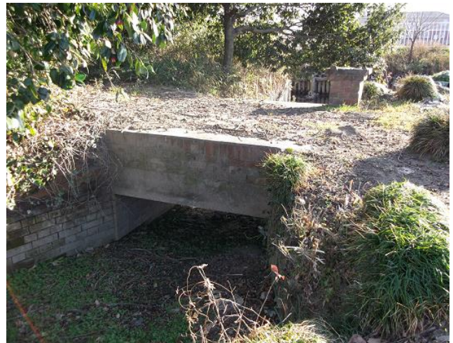
古い忍川からの分水用煉瓦造り樋管橋
