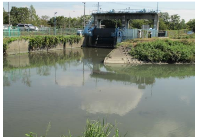
大雨時に武蔵水路に排水する佐間水門
